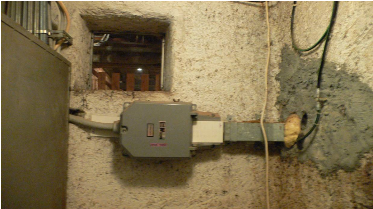
Hauptanschlusskasten
